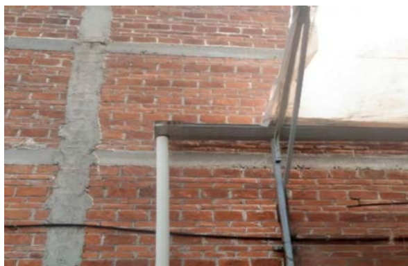
Figura 9. Gestión sostenible, con sistema de captación de agua pluvial.
